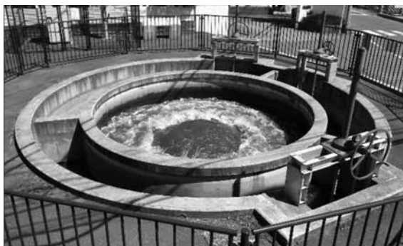
◎金野井用水路末端 円筒分水工の様子 【吉川市上内川地内】
