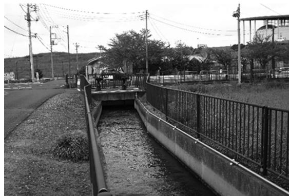
◎豊野用水路取水口 【加須市外野地内】
