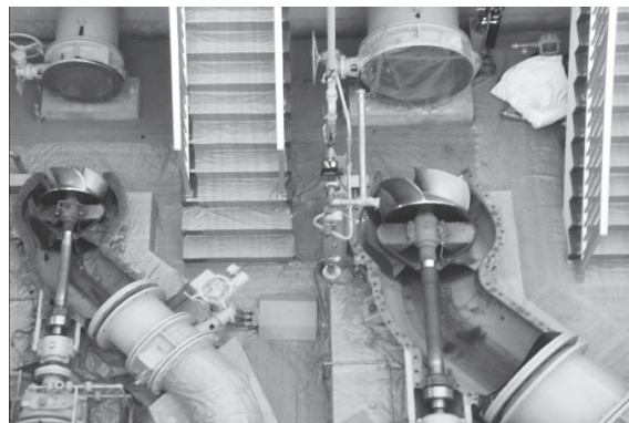
◎金野井揚水機場オーバーホール
